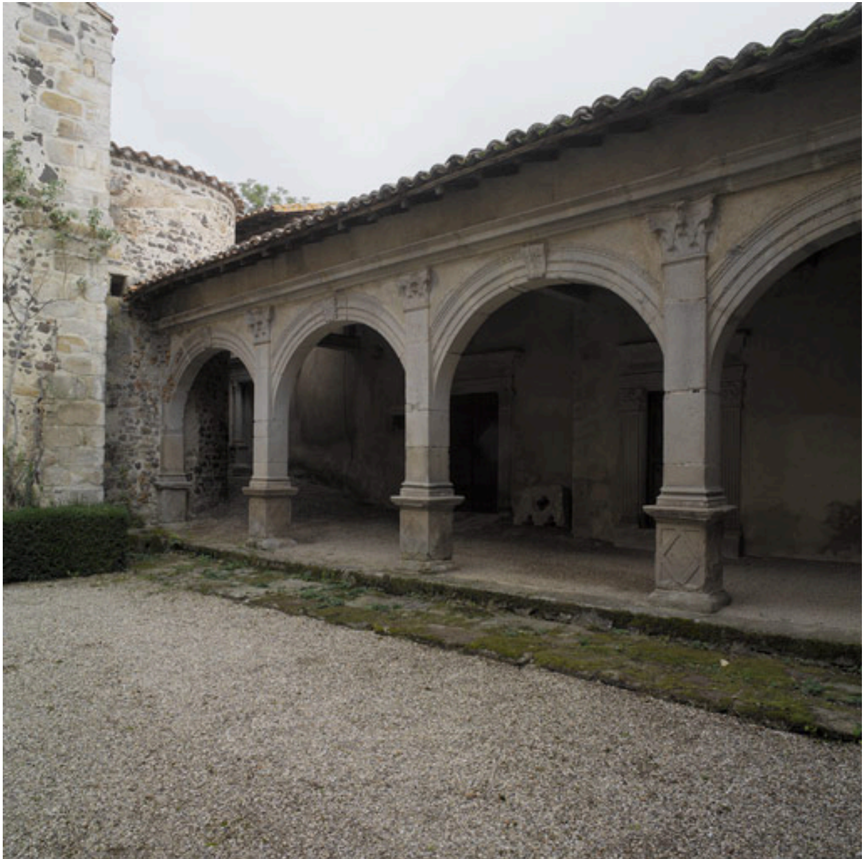
Vue de la galerie située devant l'aile est, depuis le sud-ouest.
