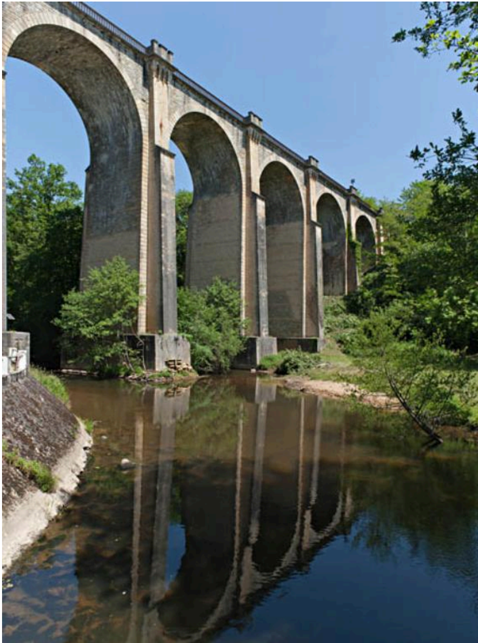
Vue de trois quarts du viaduc, côté sud, dominant la Besbre.
