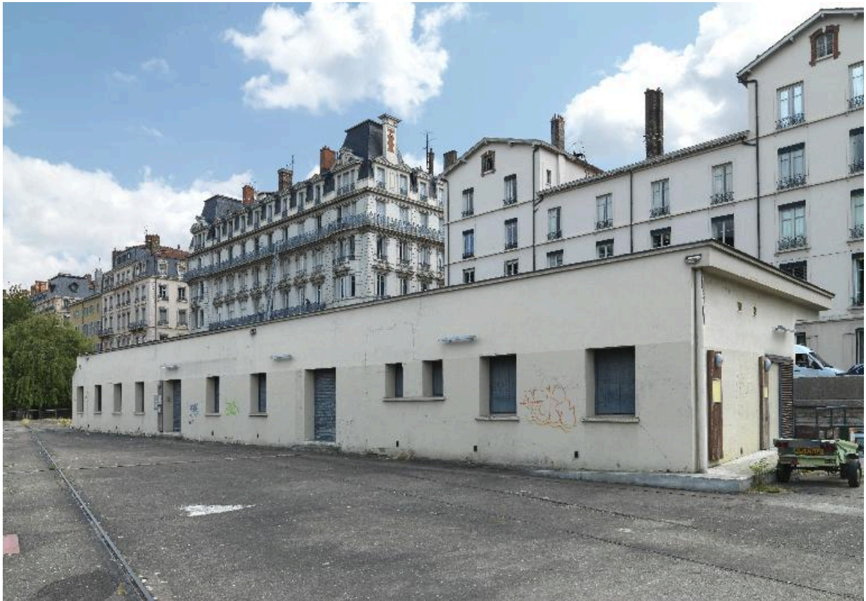
Façade sud-ouest du bâtiment des chais
