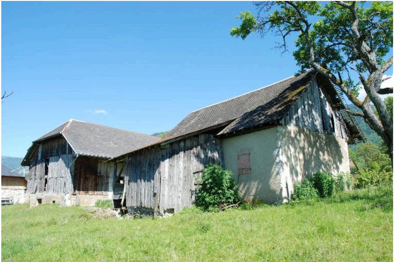
Vue d'ensemble de trois-quart de la ferme depuis le nord-ouest.
