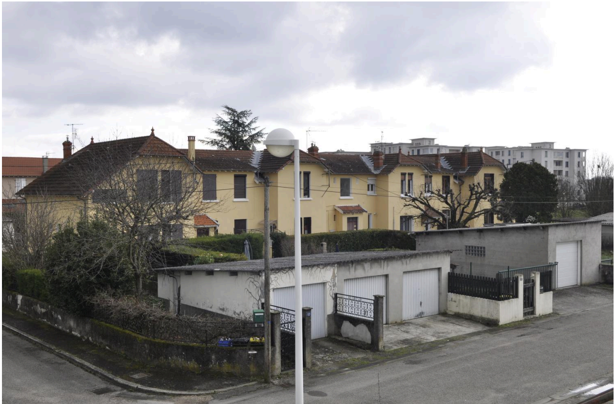
Détail maisons et garages de la cité ouvrière
