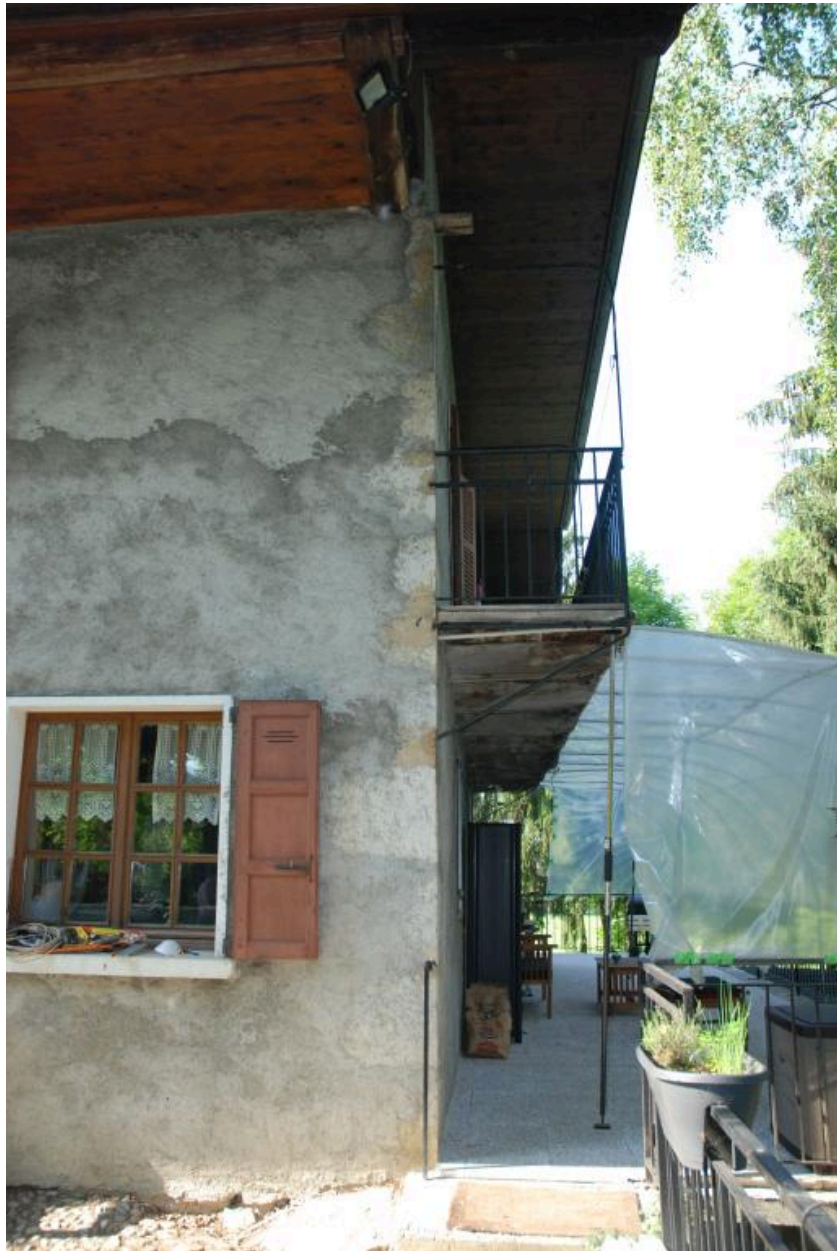
Balcon-galerie sur le mur pignon.
