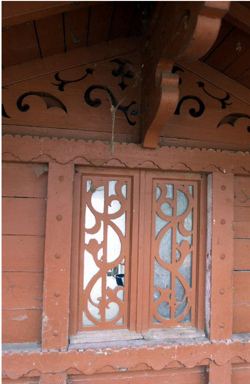
L'oisellerie, élévation postérieure : détail de la fenêtre
