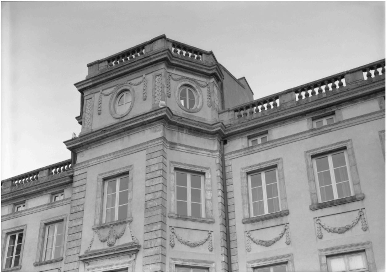
Détail de la façade sur jardin : partie supérieure de l'avant-corps central.
