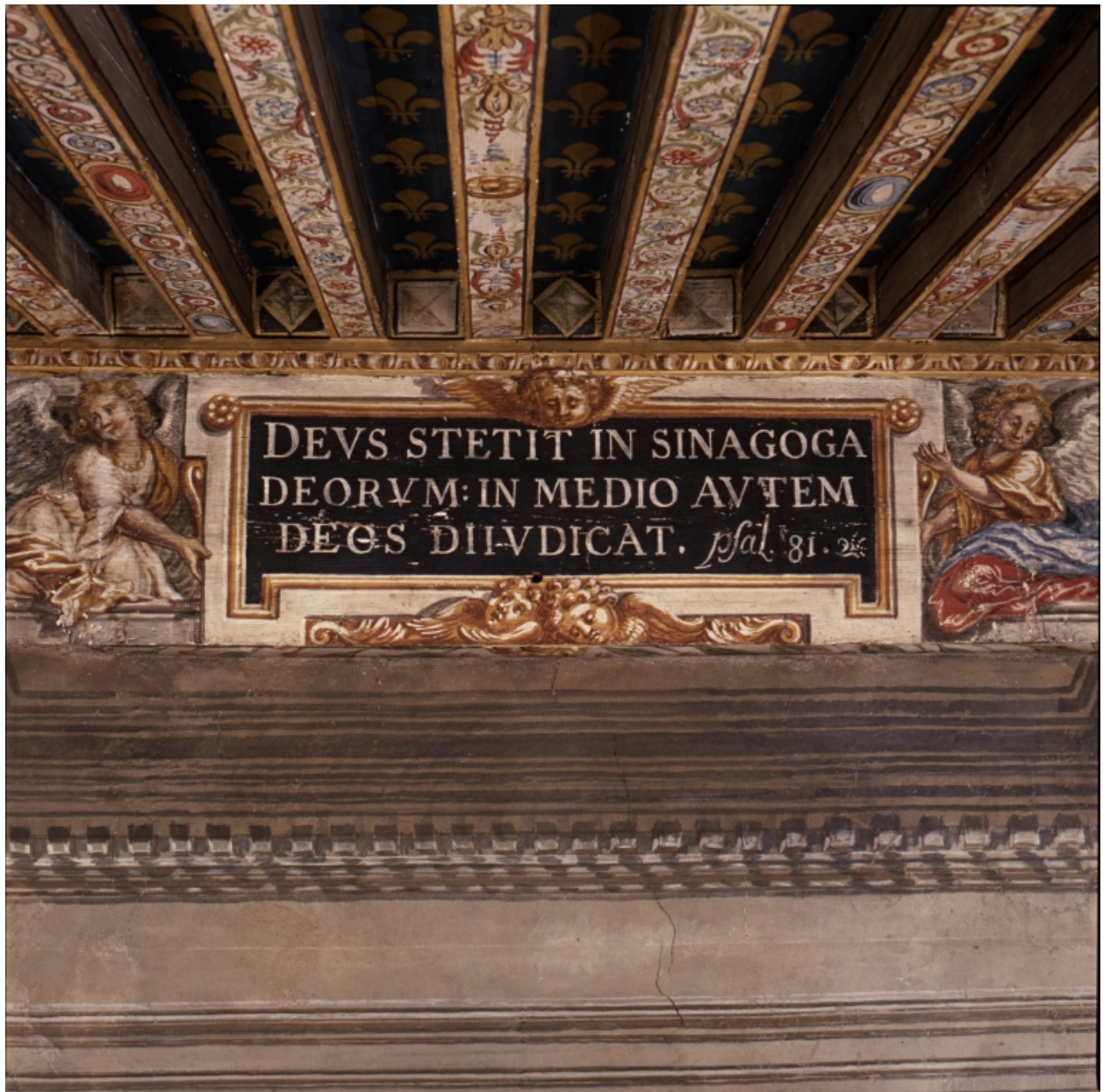
Poutre 1, face sud, cartouche axial.
