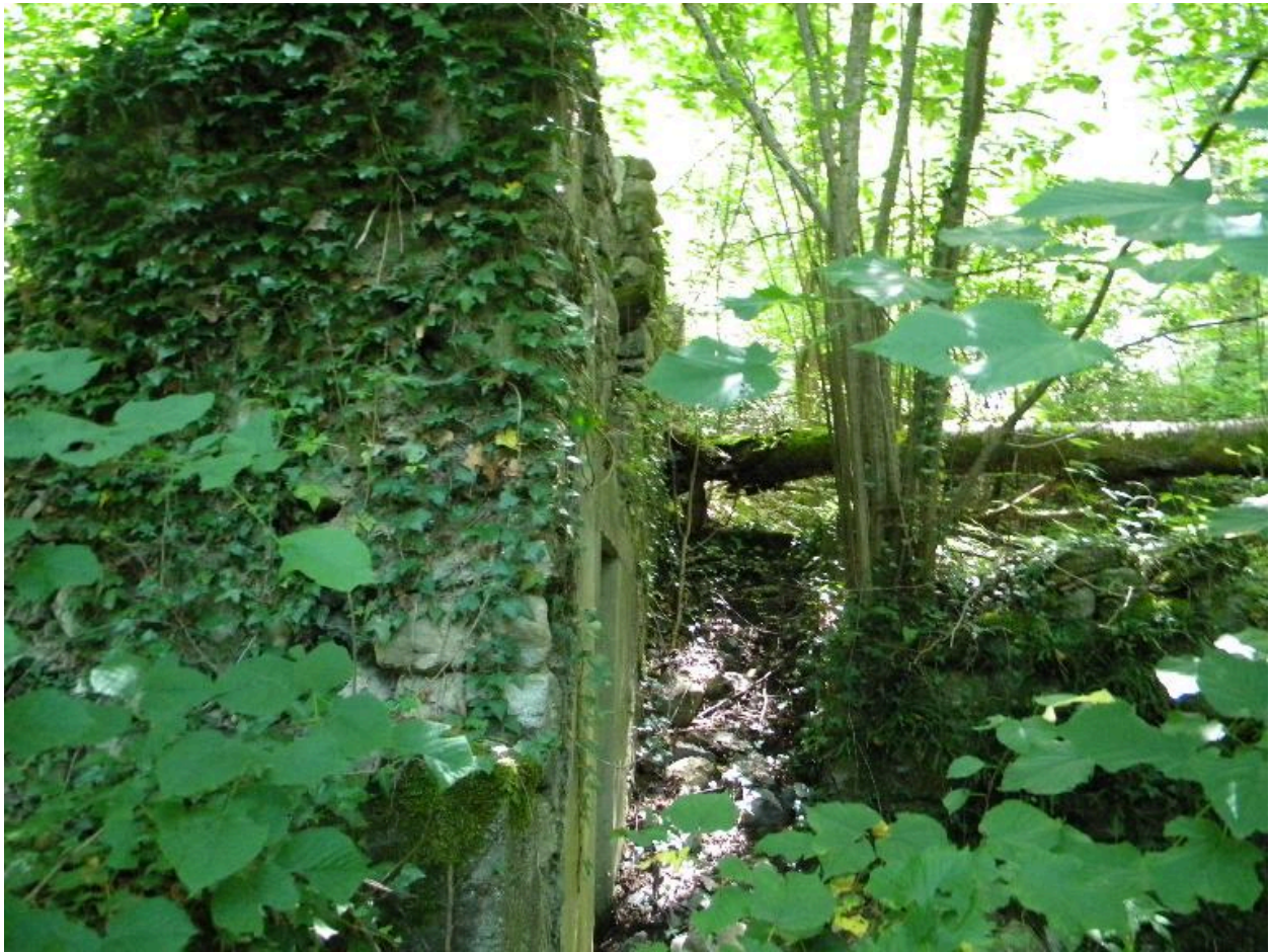
Détail d'une maison en ruine en bas du hameau (2008 D9 1819)
