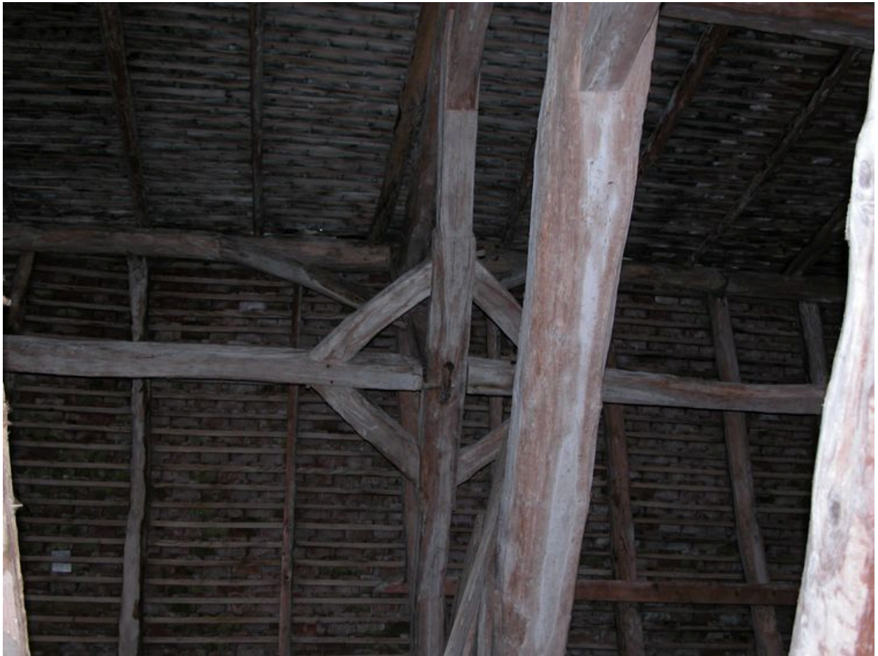
Détail de la charpente de la grange.
