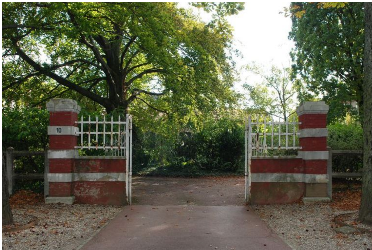
Portail d'entrée remanié du bâtiment 223
