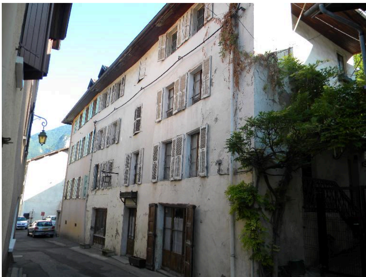
Alignement de deux façades au début de la rue Nicolas Blanc (2008 D15 2558, 4905)
