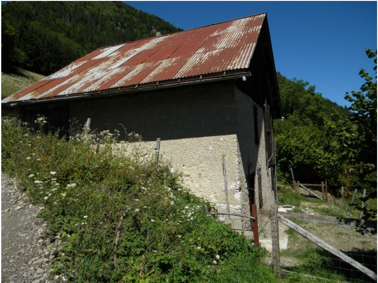
Vue de la façade sud.
