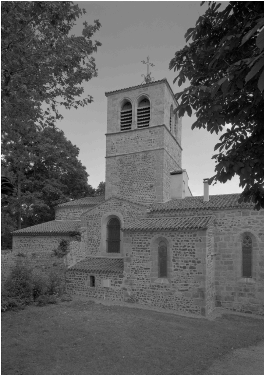
Vue d'ensemble de la façade nord.
