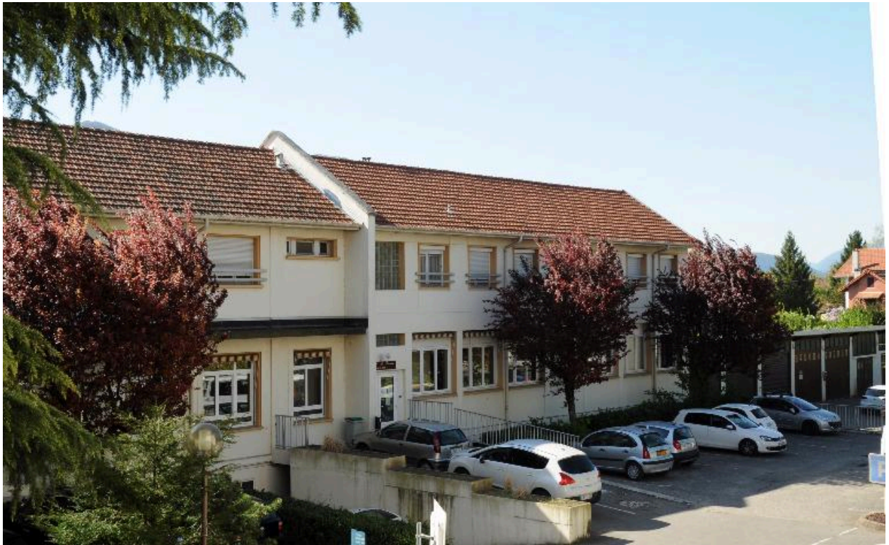
Pavillon Hubert Perrier (bât. I) et menuiserie (bât. J), vue de trois-quart gauche
