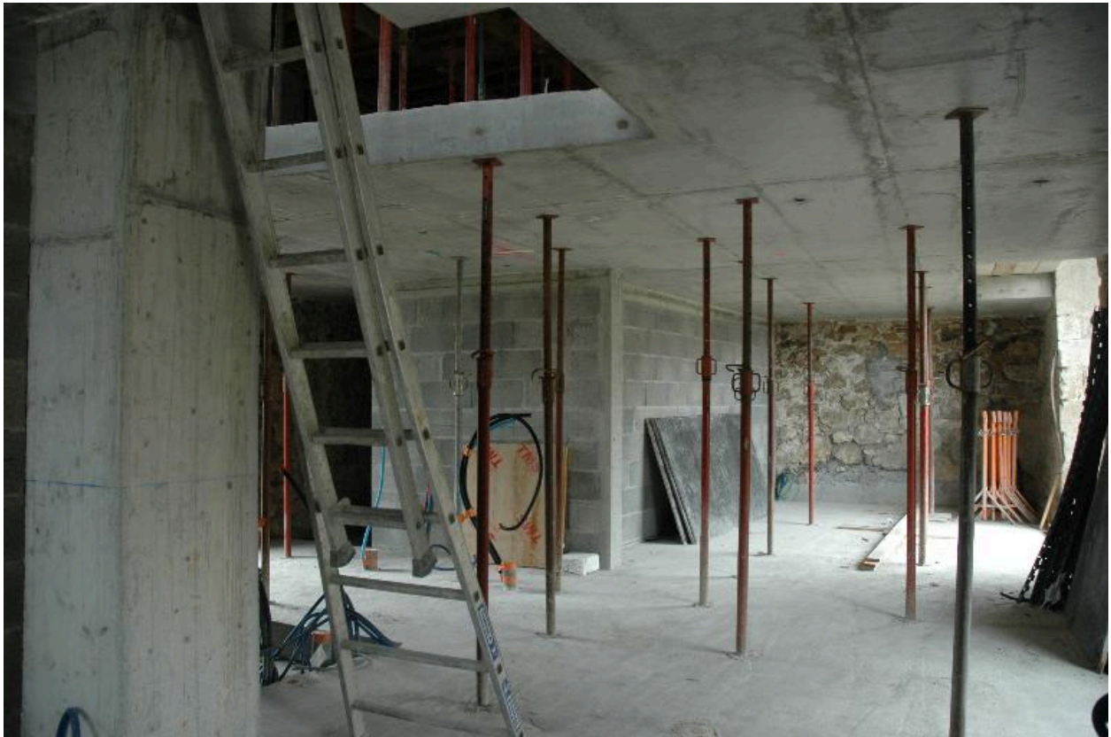
Intérieur de la grange de la ferme en cours de rénovation.
