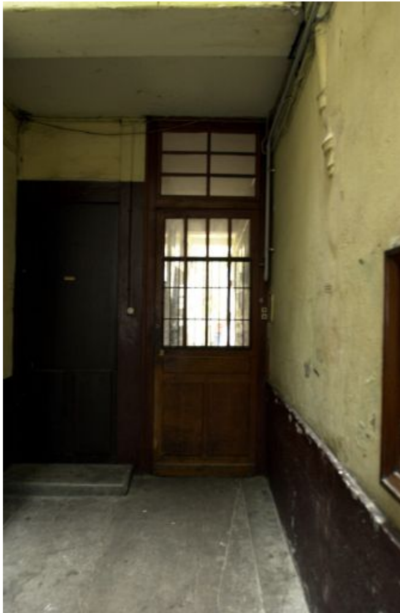
Porte et couloir d'accès à la maison en fond de cour
