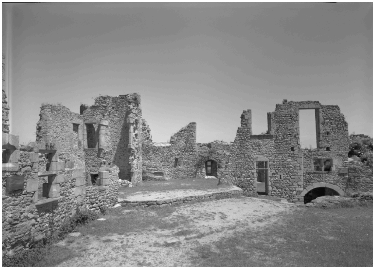
Premier baile, angle nord : vue du logis dit logis du Capitaine et du premier ouvrage d'entrée, du nord-ouest.
