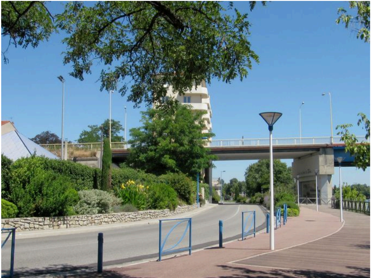
Travée de rive droite, face aval, vue générale (depuis la rive droite)
