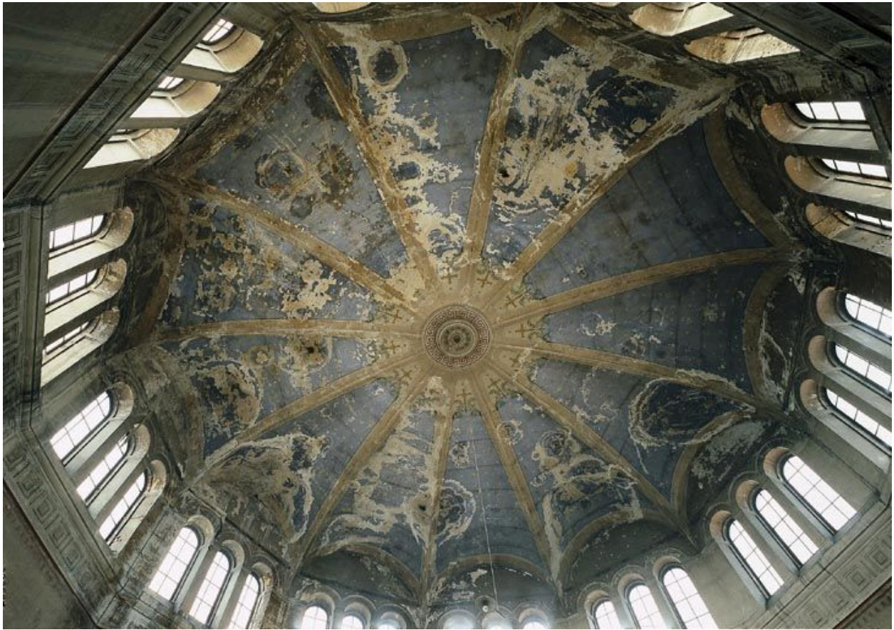
Chapelle : vue de la coupole, état en 1984
