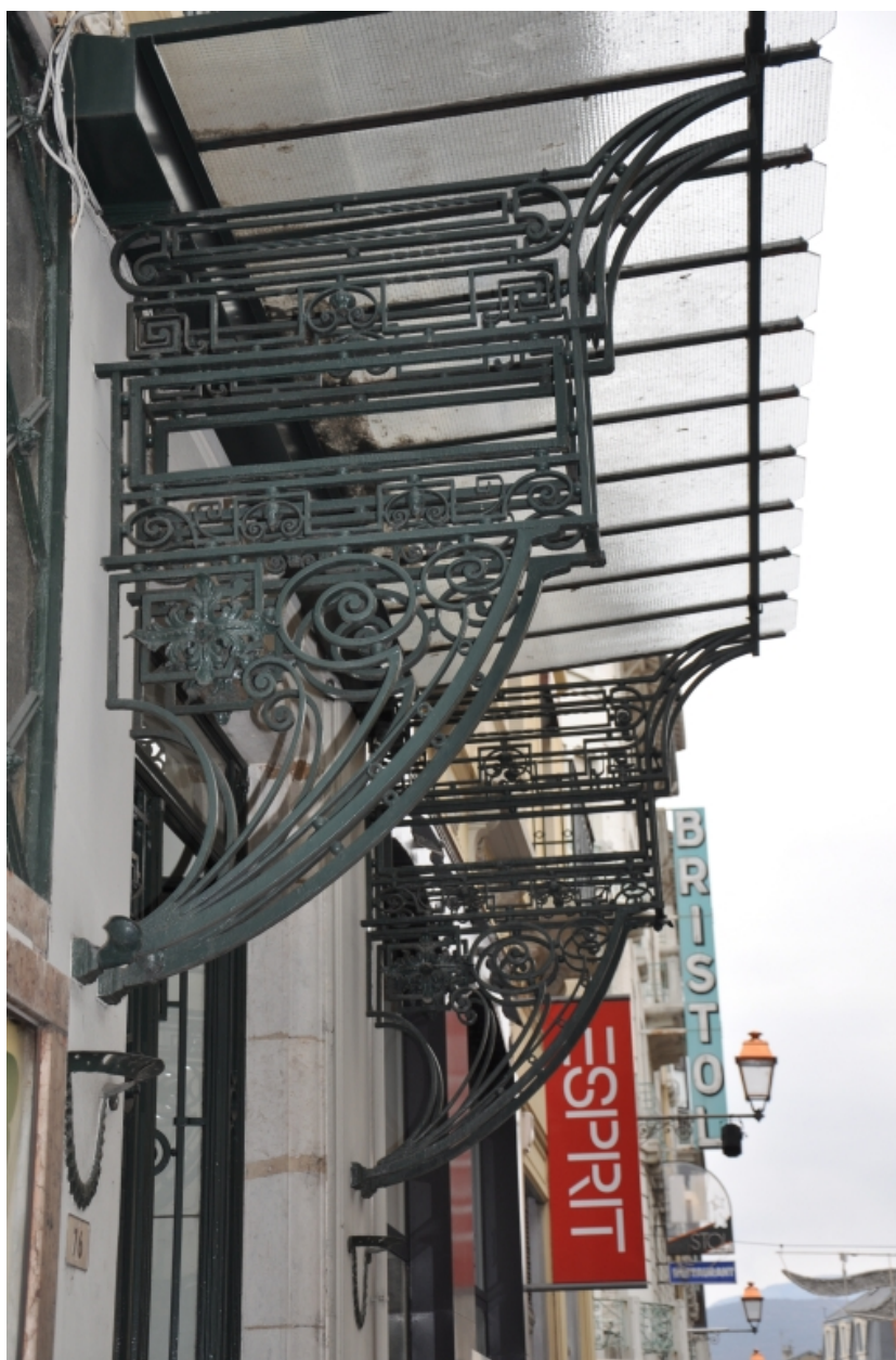
Corps principal : consoles de la marquise
