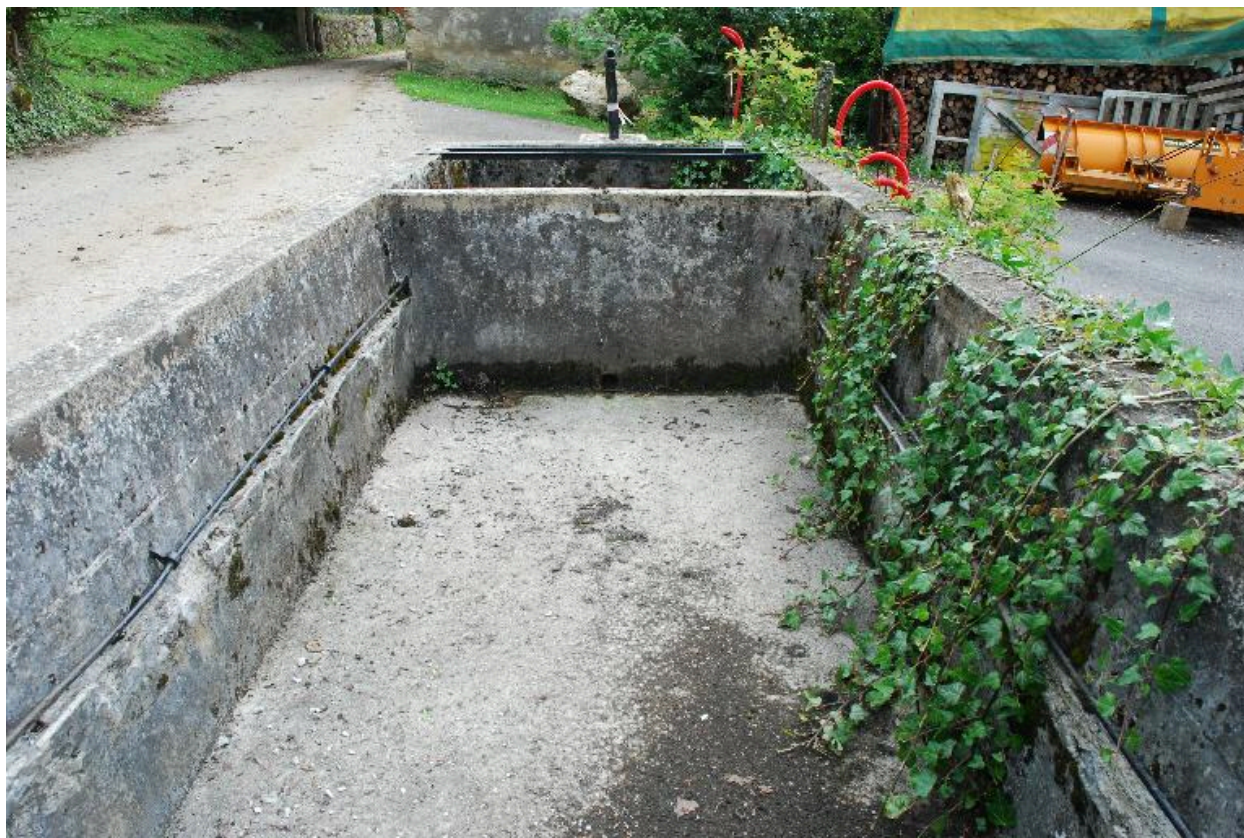
Les Huguets, Bassin, parcelle B1 937, détail intérieur.
