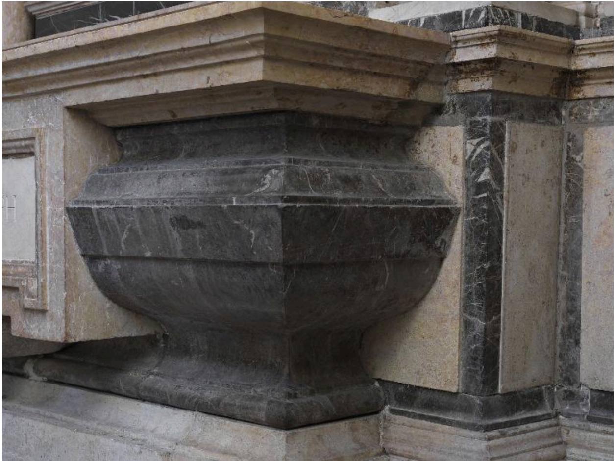
2e chapelle du bas-côté sud : détail de l'autel, vu de 3/4 droit
