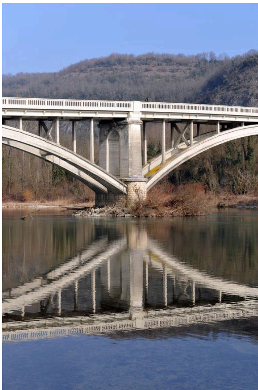
Vue partielle, pile, face aval (depuis la rive droite)
