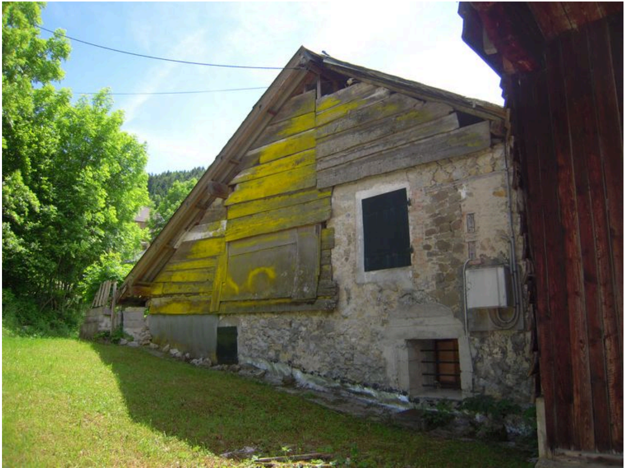
Vue de la façade nord.
