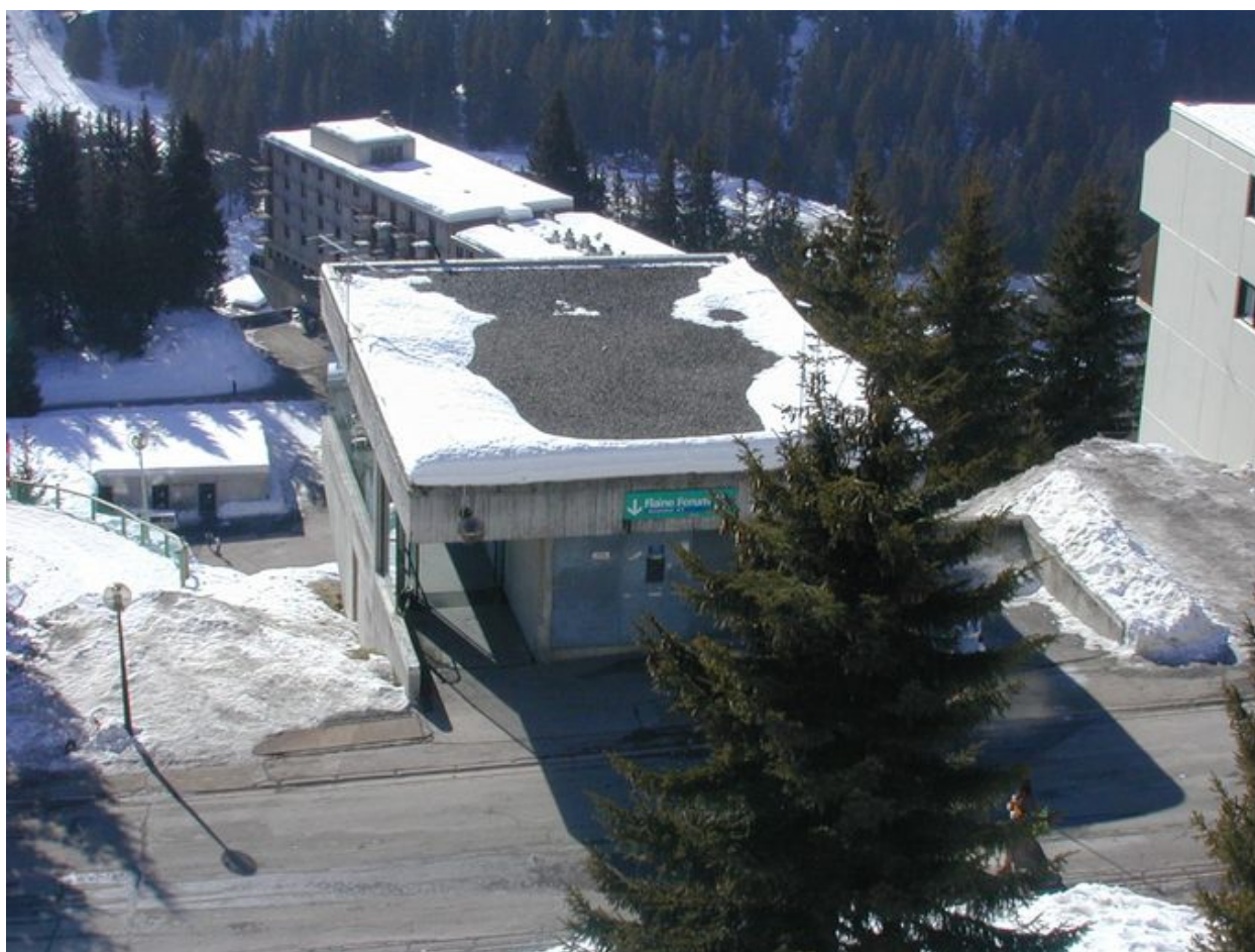
Vue du toit terrasse
