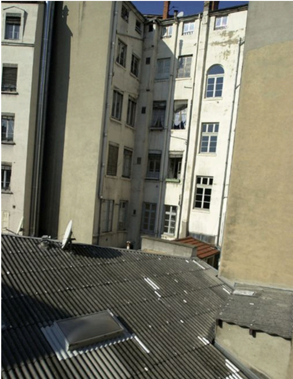
Elévation postérieure, vue de la travée d'escalier
