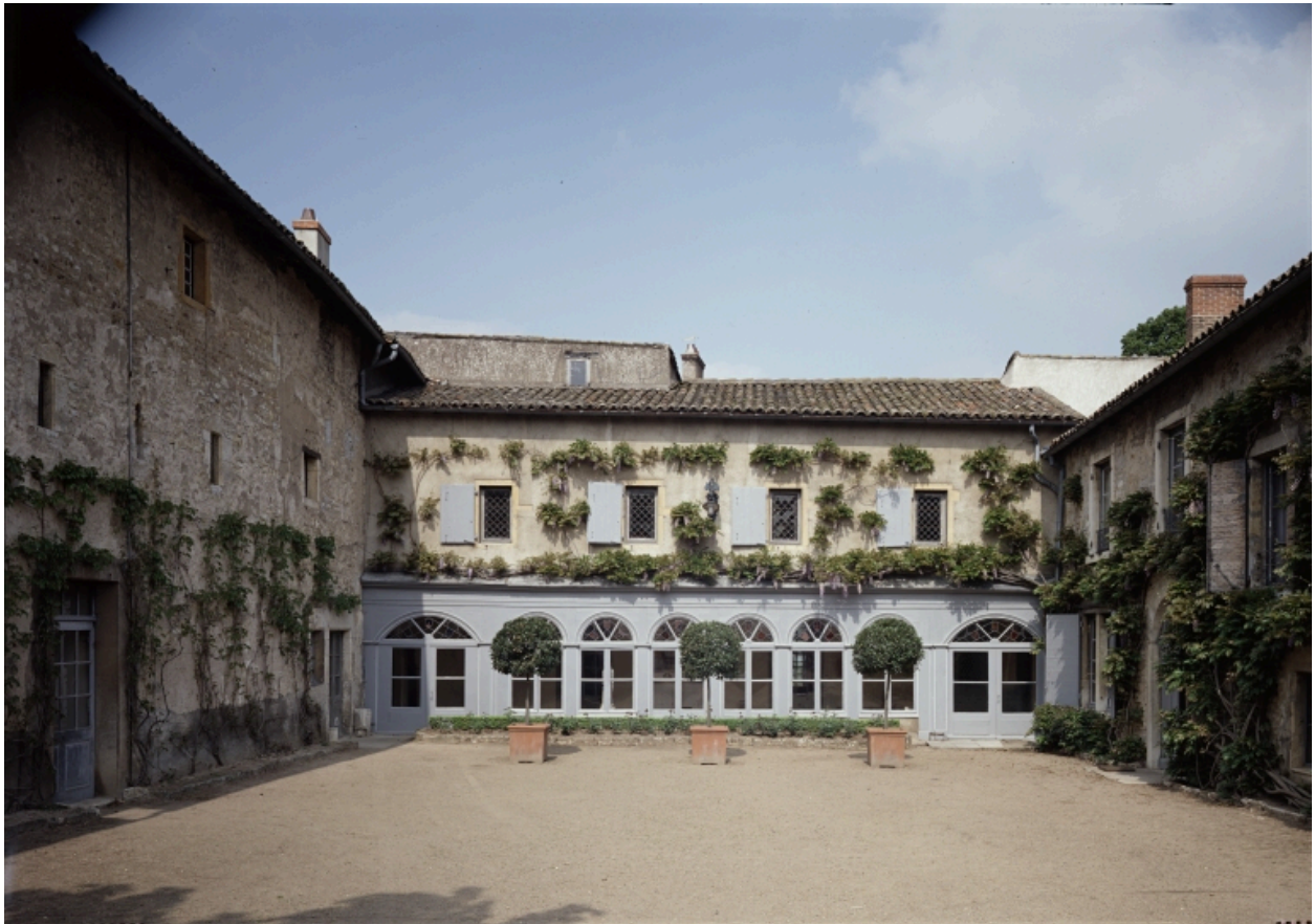
Vue d'ensemble sur la cour, depuis le sud-est.
