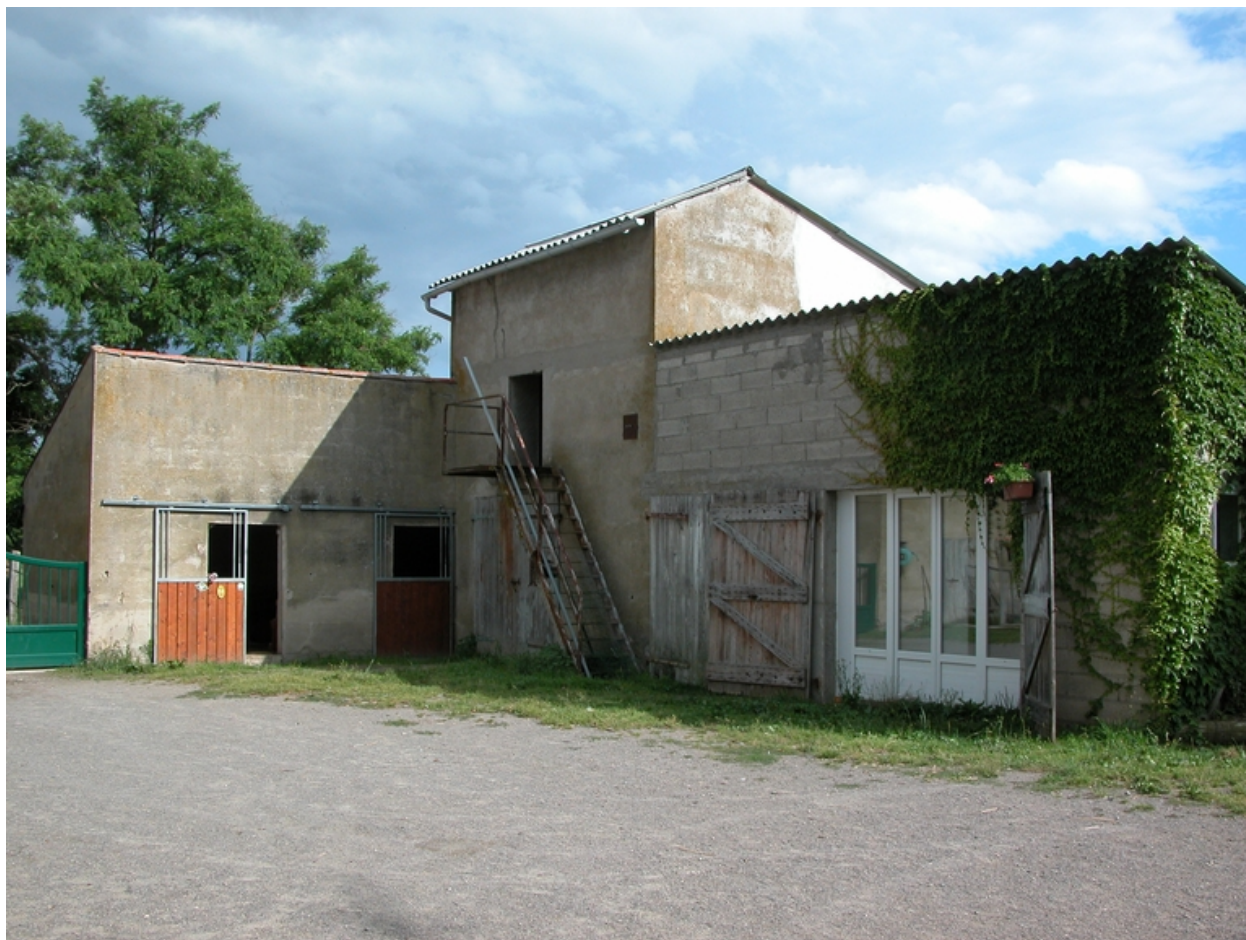
Vue de l'ancien pigeonnier.
