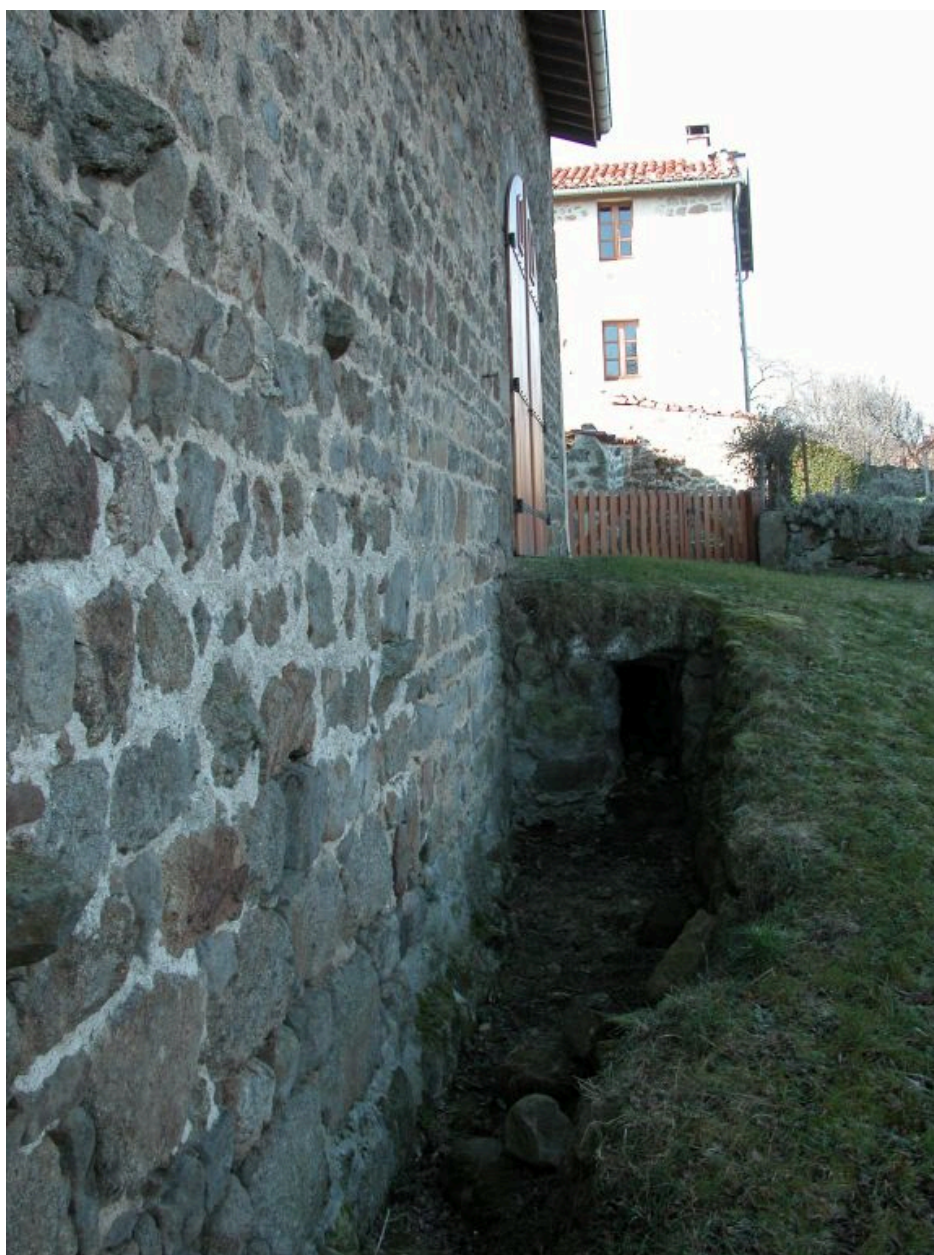
Détail du montoir de la grange-étable.
