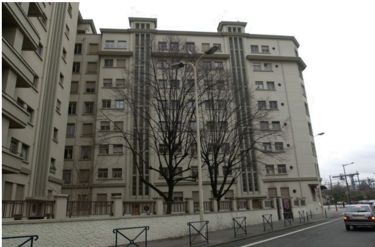
Vue de l'élévation rue Raoul-Servant depuis le nord
