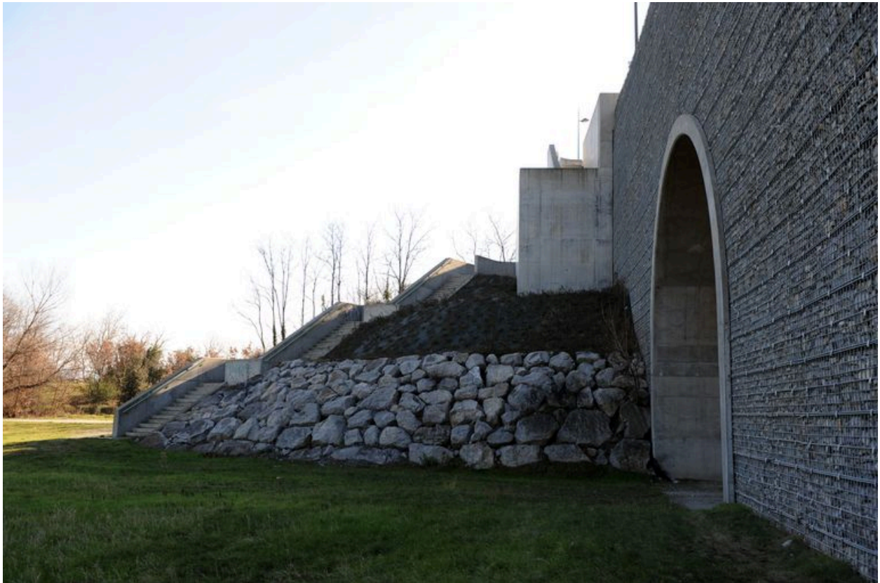
Culée droite, de côté, face amont, vue partielle : escalier d'accès (depuis la rive droite)
