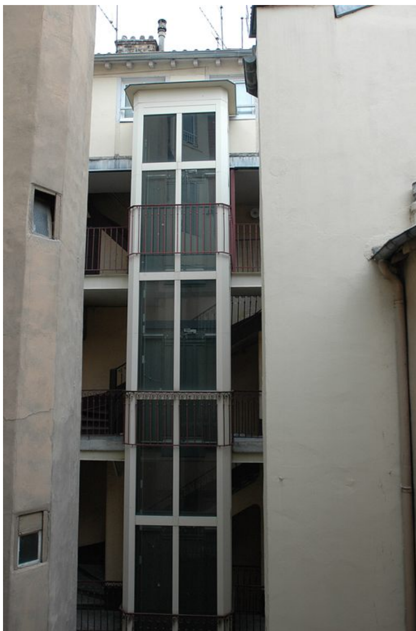
Vue de l'escalier en partie occulté par l'ascenseur, depuis la galerie de l'immeuble 6 rue Thomassin
