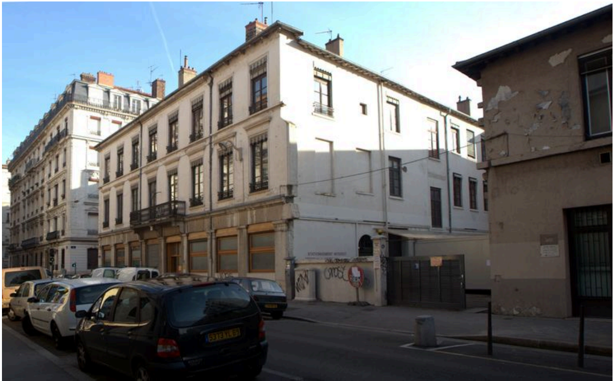
Vue générale depuis le sud-ouest
