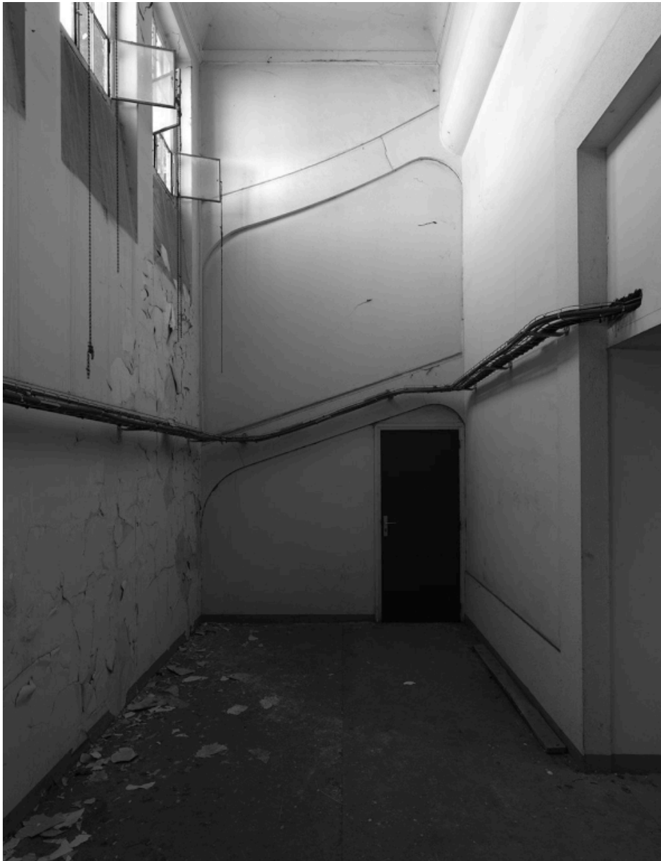
Bâtiment C. Le vestibule d'accès au dôme Pascalon
