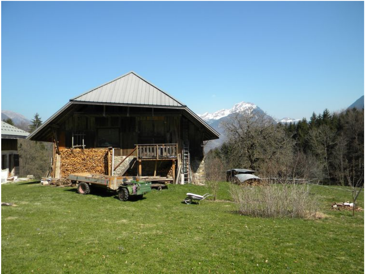
Vue du mur pignon sud-ouest.
