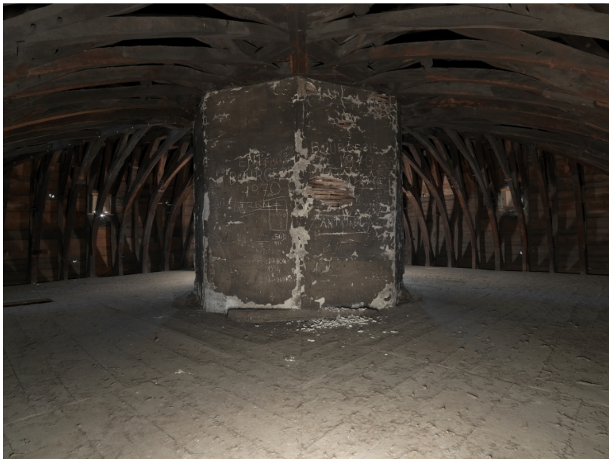
Le dôme des Quatre Rangs. 2e niveau de charpente. Vue d'ensemble avec la base du lanternon au centre
