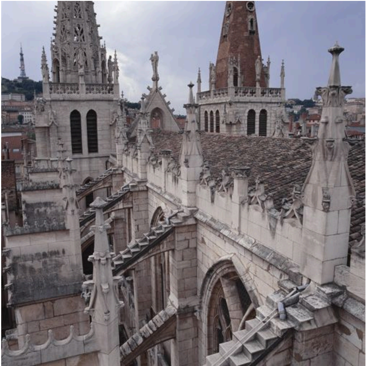
Elévation sud de la nef, arcs-boutants
