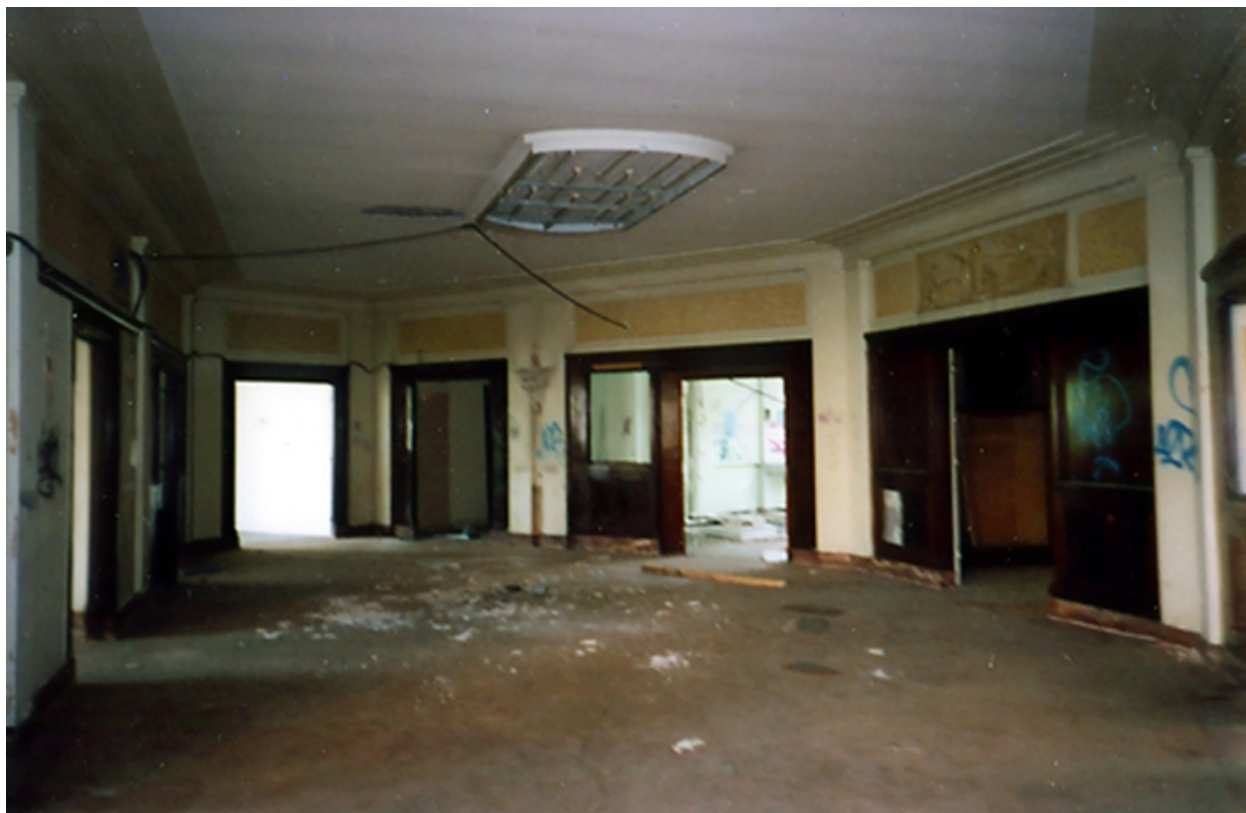
Vue intérieure, hall d'entrée
