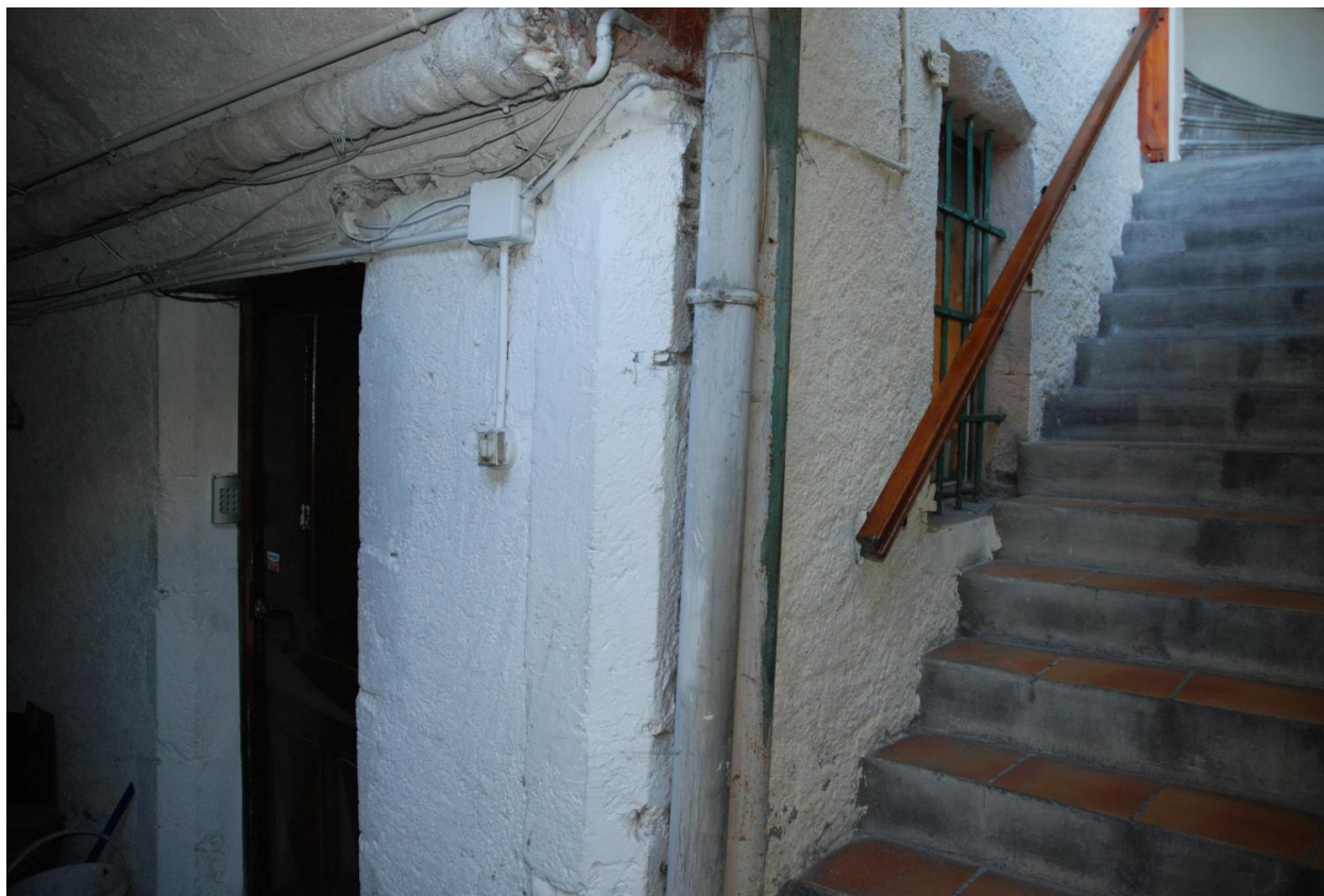
Maison, immeuble, 94 rue Louis Blanc-Pinget (2018 E1 1244). Escalier.
