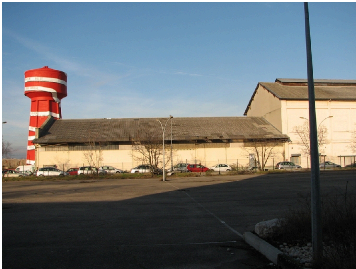
Vue du château d'eau
