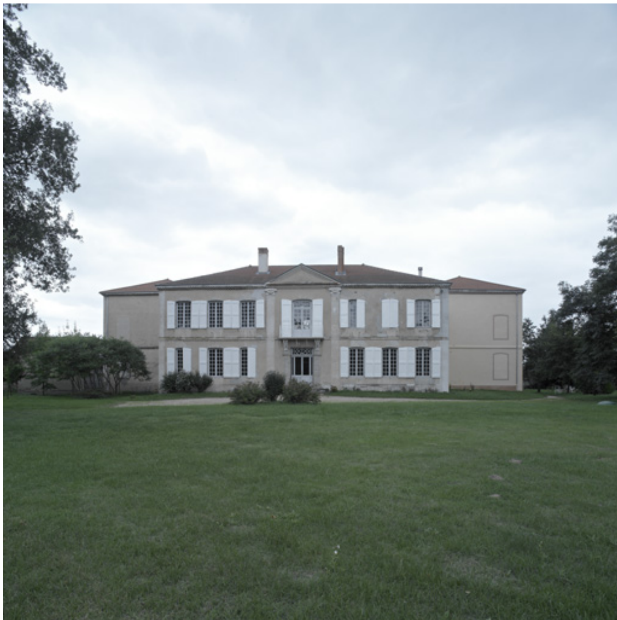
Vue d'ensemble de la maison de maître, depuis l'ouest.
