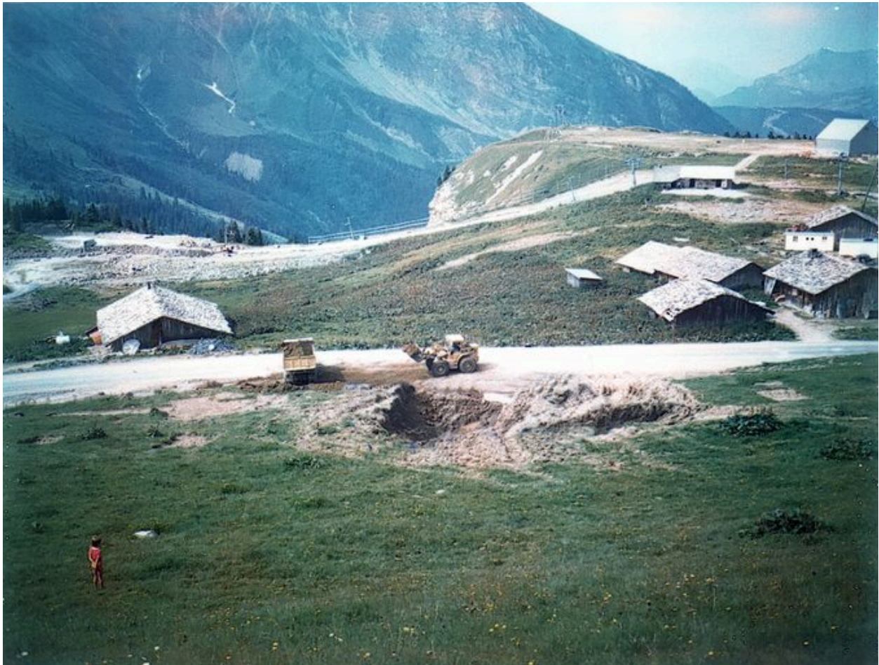
1970, aménagement de l'altiport sur le rebord de la falaise (en arrière plan, les chalets d'alpage)
