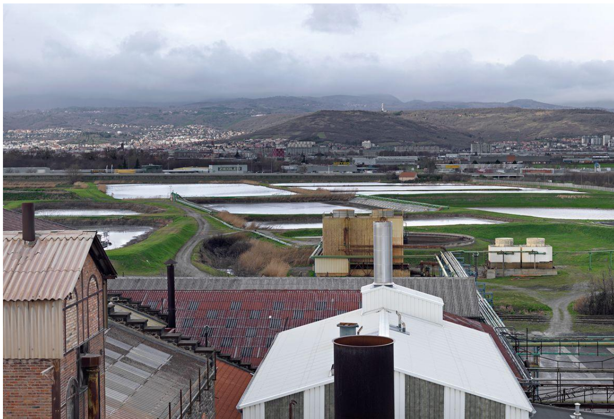
Vue des bassins de lagunage
