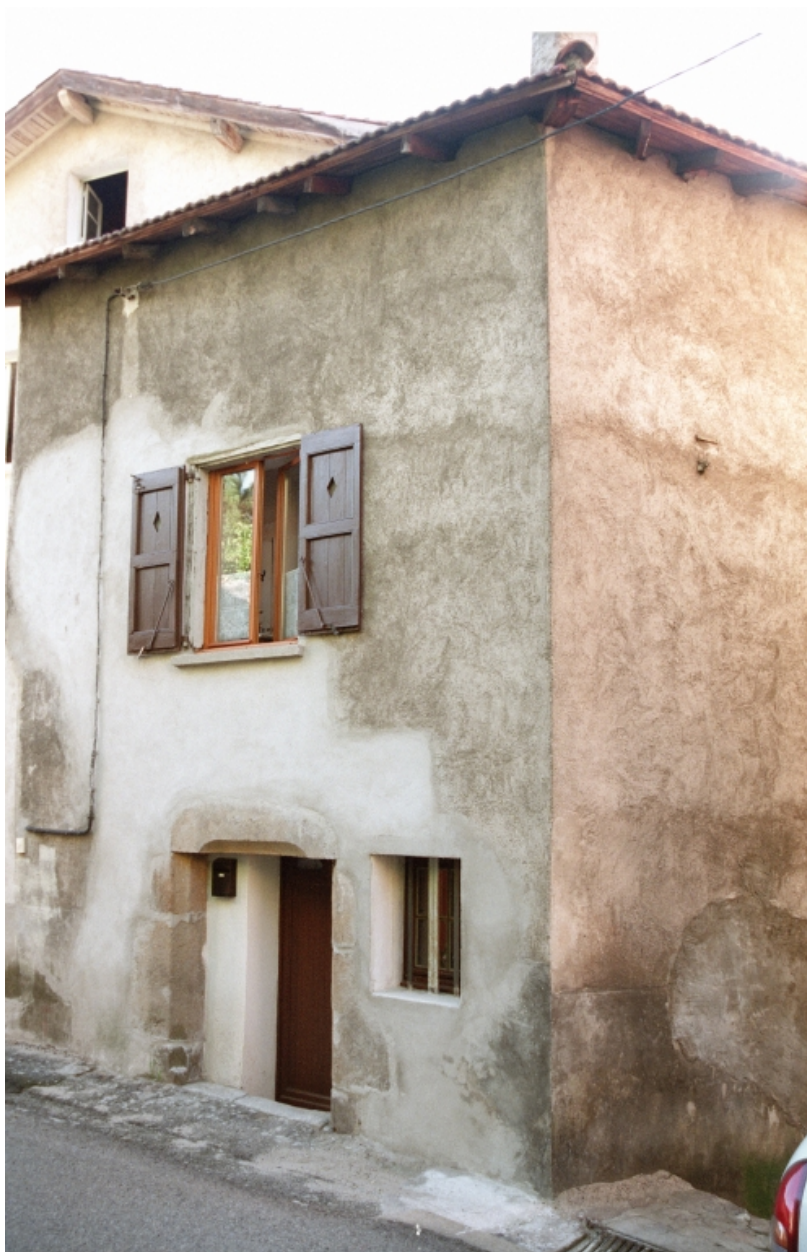
Boën, îlot 13, Ph. Raymond (rue) 42. Vue générale de la façade sur rue.
