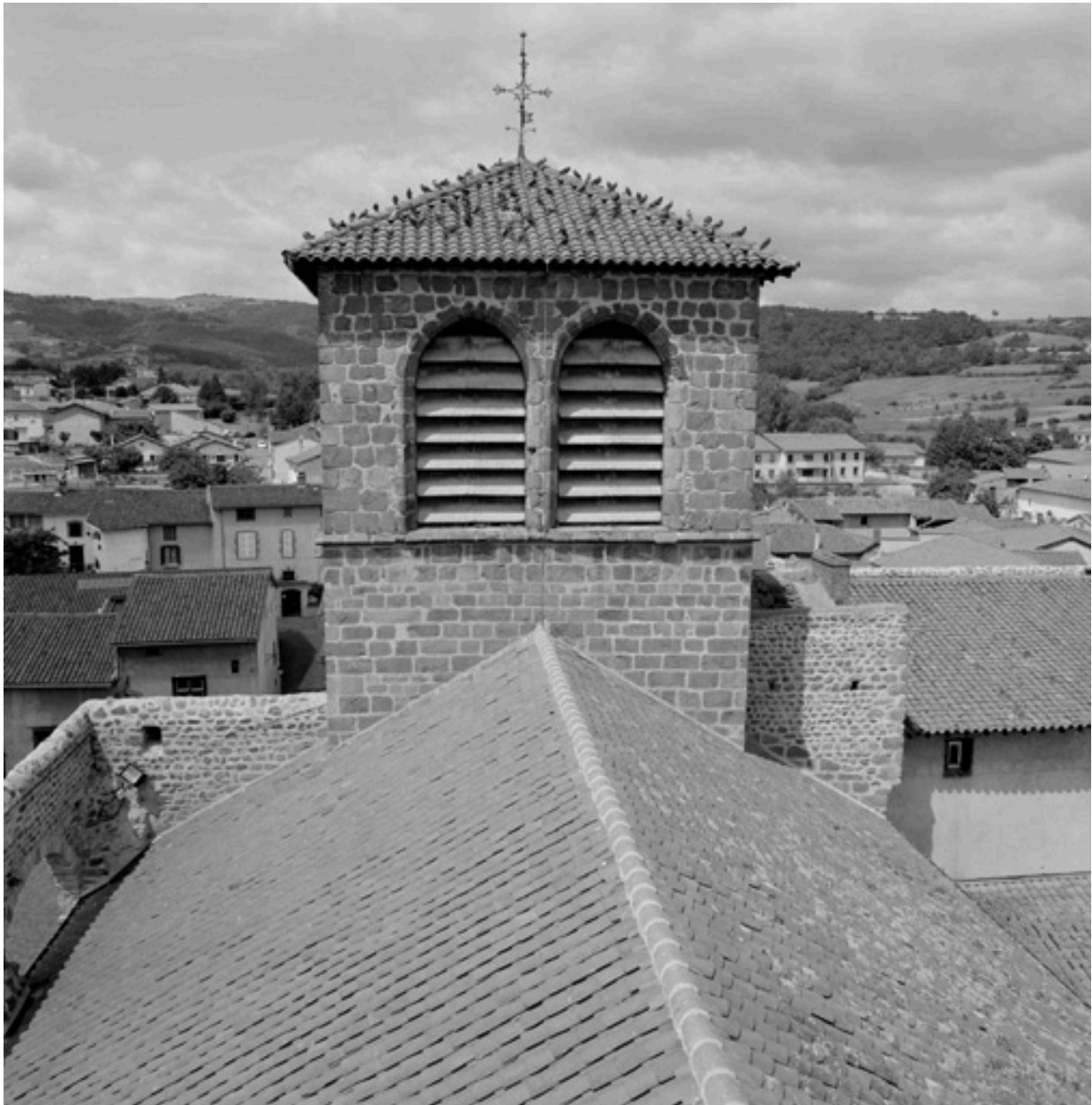
Vue du toit de la nef et du clocher porche, depuis le clocher de la croisée.
