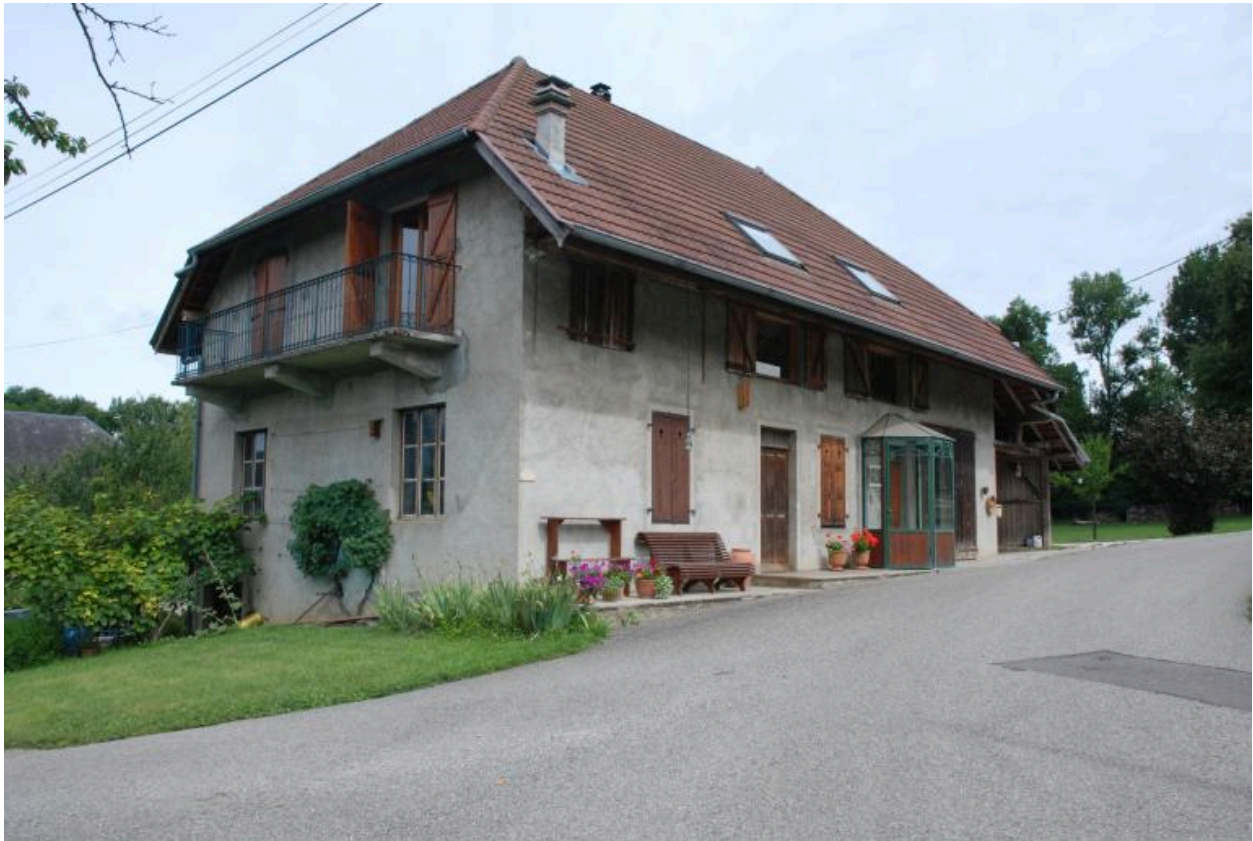
Vue de l'atelier de menuiserie, depuis le sud-est.
