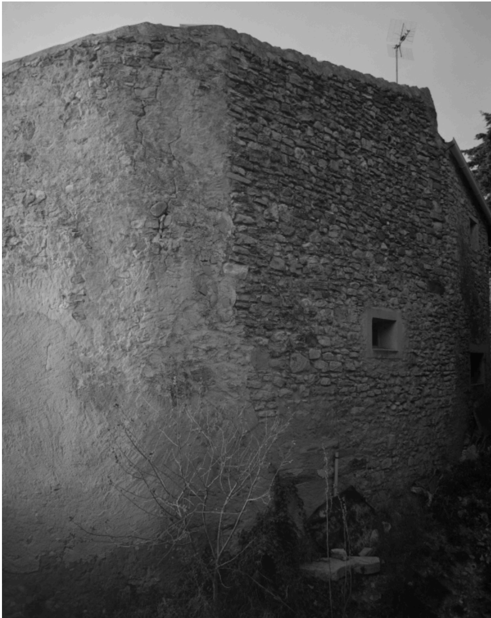
Le Pègue, Village. Maison (B3 650), élévation postérieure sur la butte castrale.
