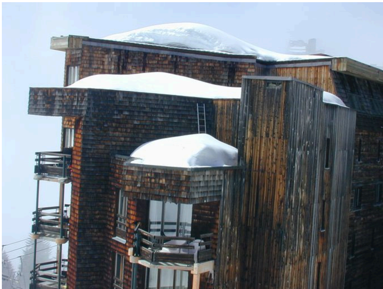
Détail du pignon sud et des toits terrasses
